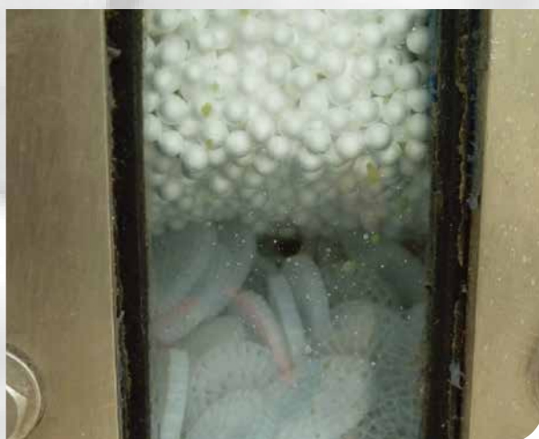
BIOSTYR® 生物滤池中的双层滤料
